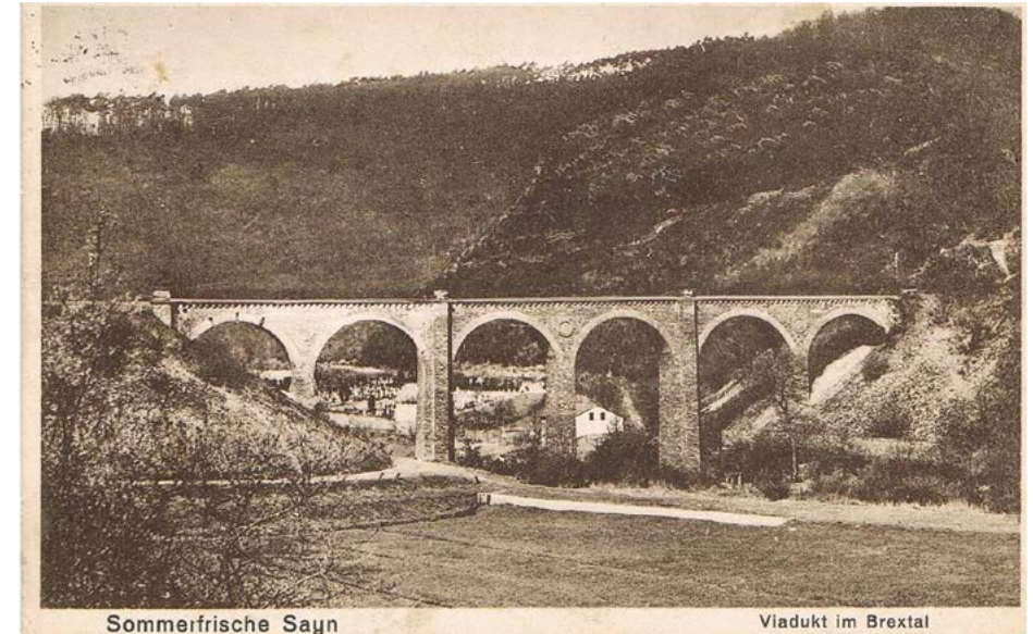
Abb. 7: Das erste Viadukt auf Strecke Sayn-Grenzau. In der Mitte das Haus für die Unterbringung der Bauarbeiter; im 2. Brückenbogen v. li. ist die Leichenhalle des Sayner Friedhofs zu sehen. Zwischen Sayn und Grenzau gibt es 5 größere Viadukte und zahlreiche kleinere Brücken sowie 6 Tunnel.
